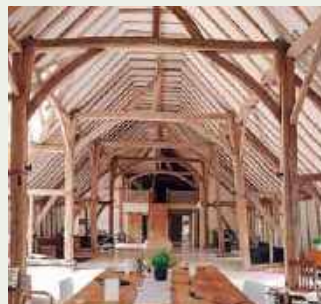
Rénovation d'une grange du 17 ème siècle avec chauffage au sol dans l'Essex (Royaume-Uni). Aquarea
