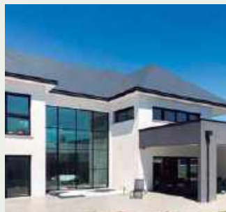
Maison de 610 m 2 avec plancher chauffant et ECS à Saint-Prest (France). Aquarea
